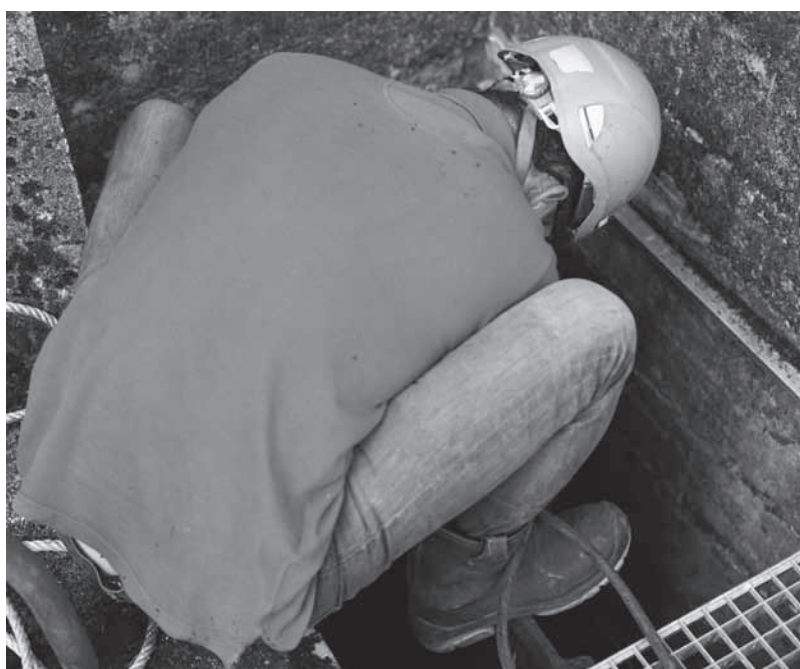
Maxence Rifflet, Pose d'un batardeau, barrage du Chastang, septembre 2012
