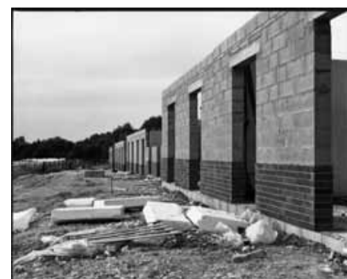
Chantier de la ZAC du bois, Douchy-les-Mines, le 20 juillet 2010
