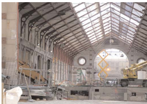
début des travaux en 2003
