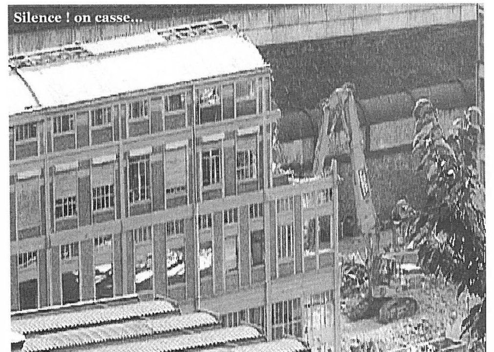
La Manu, bâtiment industriel avec toiture à voûtes rondes, construit en 1916.
